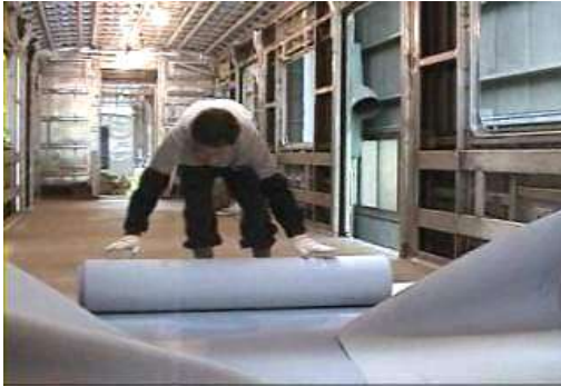
그림 109. 리노륨 시공 - 리노륨 깔기
