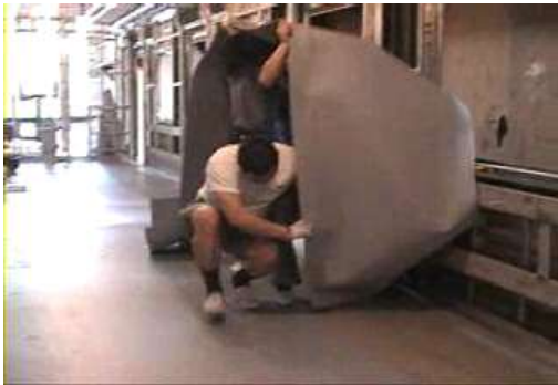
그림 111. 리노륨 시공 - 리노륨 깔기
