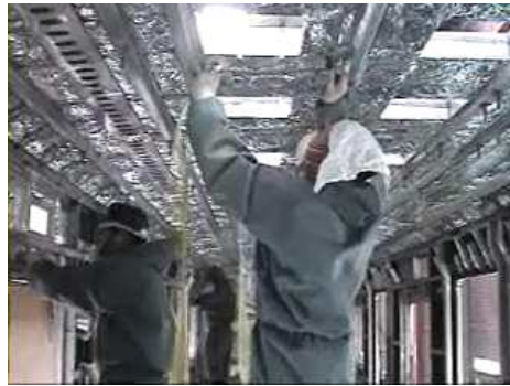
그림 108. 단열재 시공 - 천정
